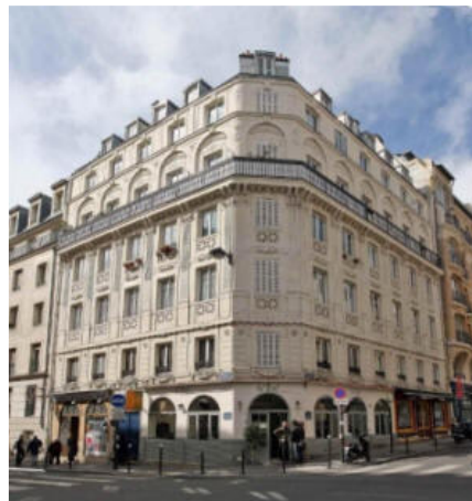
Belle maison en plâtre, À l'angle des rues Blanche et de Douai, 9 e
