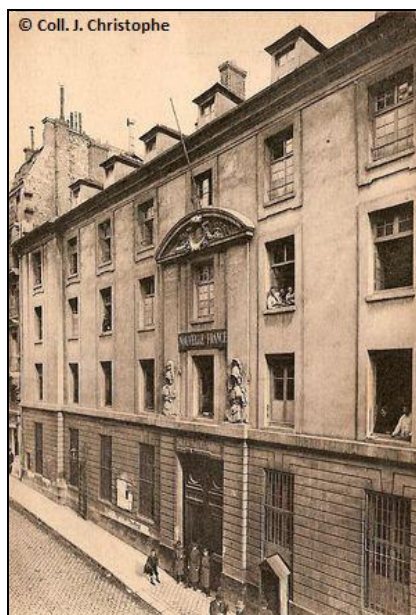
La façade sur rue dans les années 1900
